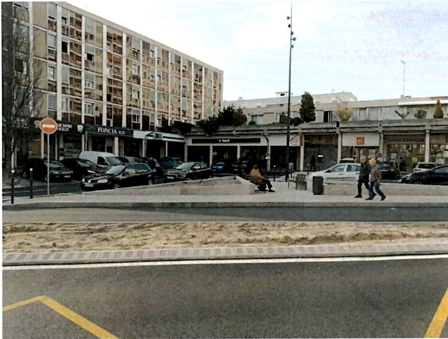
Rue Jean Jaurès - après
