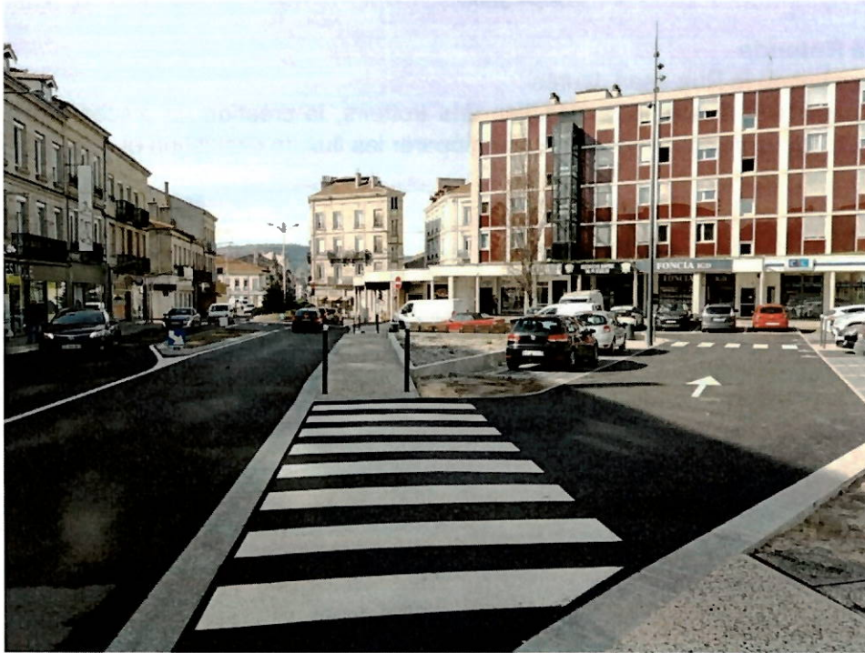
Rue Jean Jaurès - après
