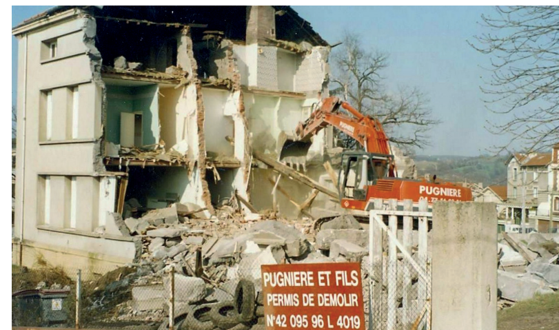
Démolition de l'ancienne villa Reymondier, ancienne maternité provisoire de Firminy, en haut de la rue Michelet
